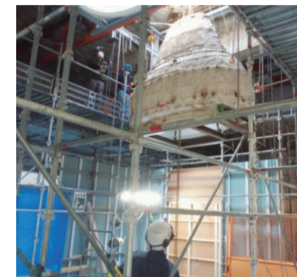
◀石こうドームを天井から降ろし補強。補強後は約1トンにもなりました
