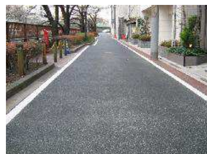
＜保水性舗装した道路＞
