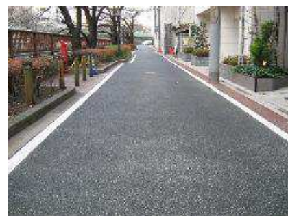
<保水性舗装した道路>
