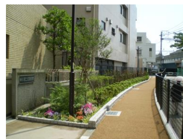
<新たに設置されたスロープ>
