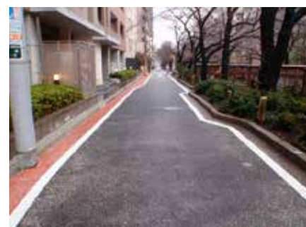
<保水性舗装した道路>
