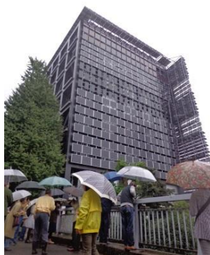
<第3回 東工大で身近な環境を考える（太陽光電池パネル）>
