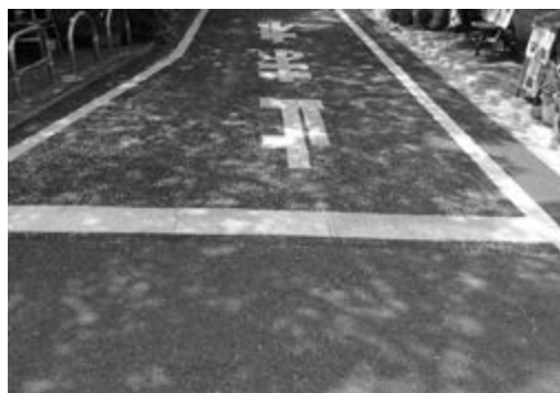
＜保水性舗装した道路＞
