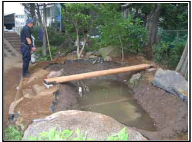
下流側は、岩石園で使われていた岩石で土止めを行った。
