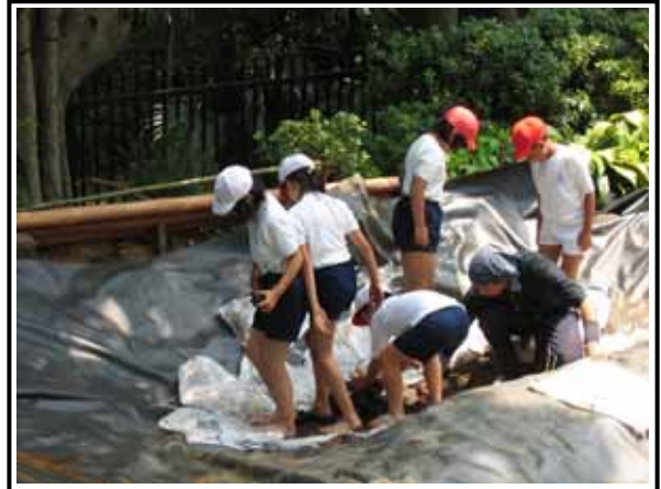
泥付け作業では、裸足になって貼り付けを行った。
