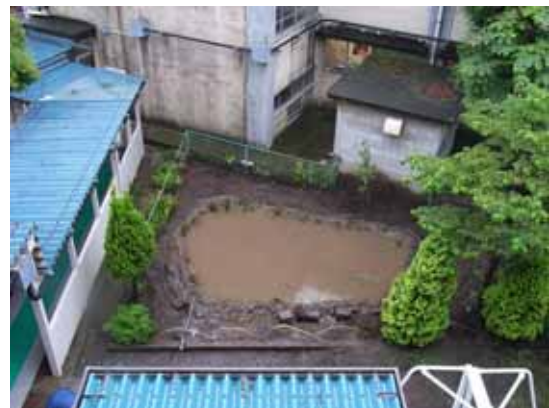
泥を付け終わった後、水を入れて深さを確認しながら岸边づくりを行い、水草を植えた。
