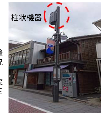
図 ソフト地中化方式のイメージ
