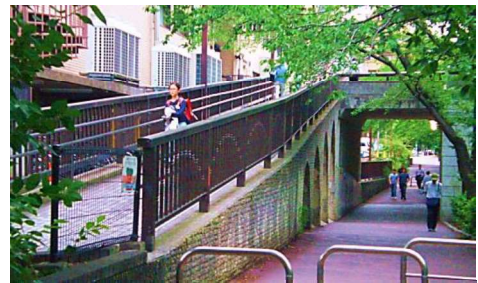
ふれあい橋と区民センターの接続
