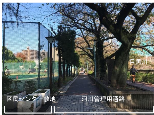
河川管理用通路
