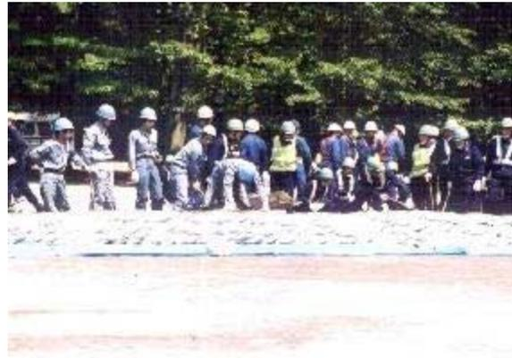
図-2 区・消防団による積み土のう工法
