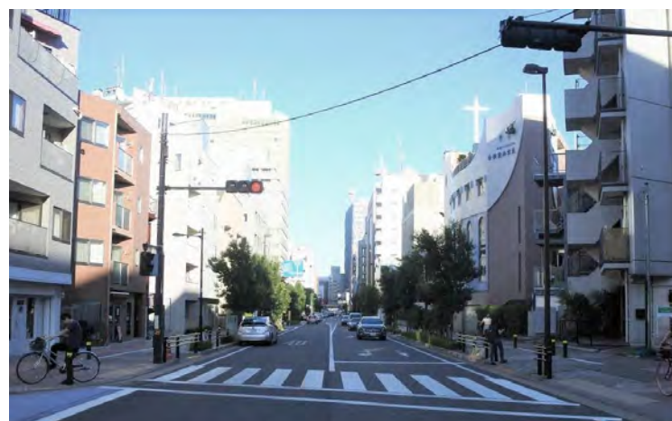
4 46 の計画と同じ、幅員 20mで整備された道路
