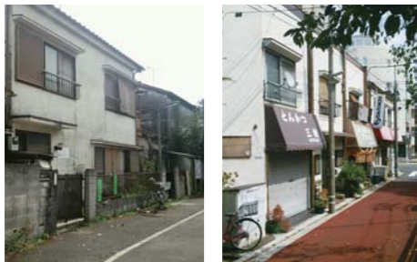
地区北側の状況
