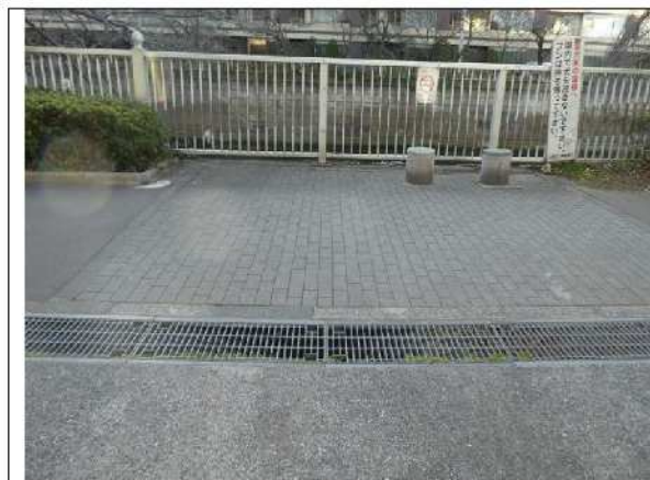
現地写真① (取水施設設置予定位置)
