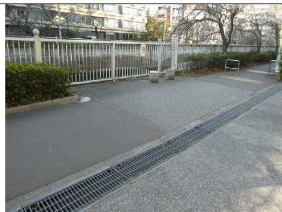
現地写真② (取水地点より上流)
