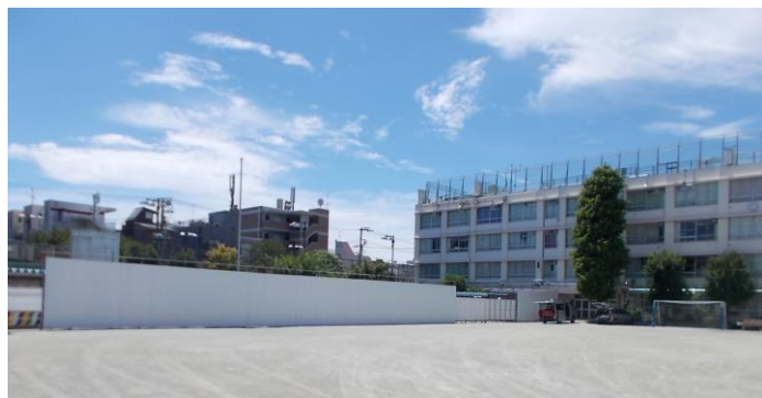
▲仮囲いの様子
