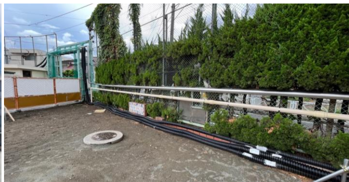
▲配管・配線ルートの確保
