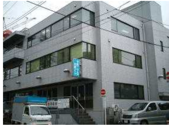
(共同ビル外観)
