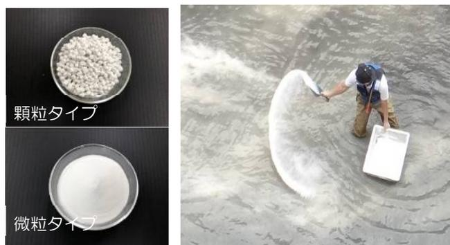
写真 6 底質改善材（左）と散布の様子（右）
