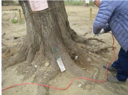
ファインノズルによる圧縮空気を 用いた細縦穴掘削作業中
