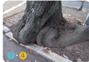
①・④ 植栽空間が狭く根を伸ばせない→根上がりして、根が舗装を壊してしまいます
