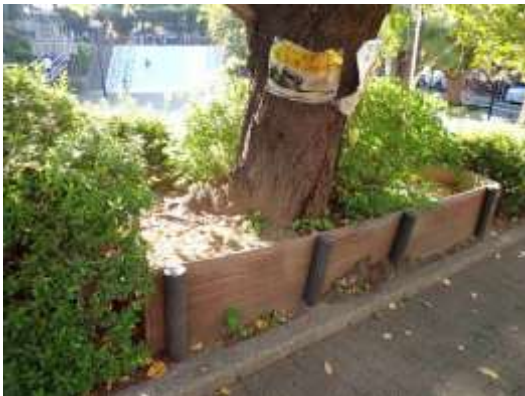
不動公園 外周柵機能植栽帯 土壤の高さを切り下げのような工事がされており、高植状になっている
