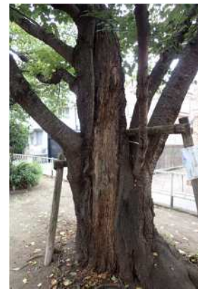
根元から大枝にかけて発生した大規模な腐朽
