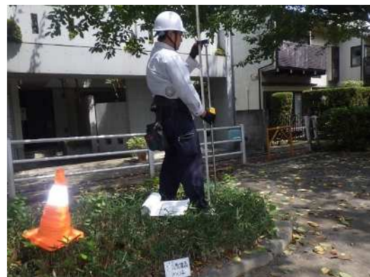
長谷川式土壌貫入試験状況
