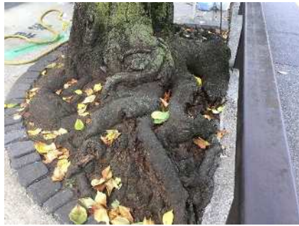
露出根が多く発生
