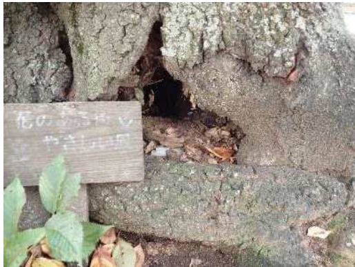
腐朽し空洞となった根元
