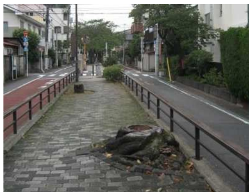
伐採により疎になっている区間
