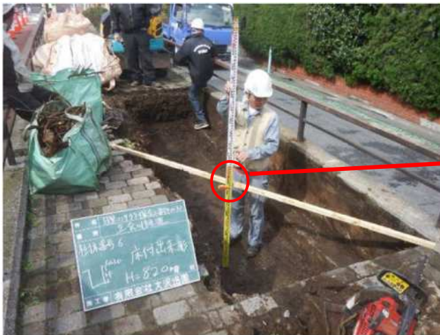
抜根工事の際に確認された土の深さ
