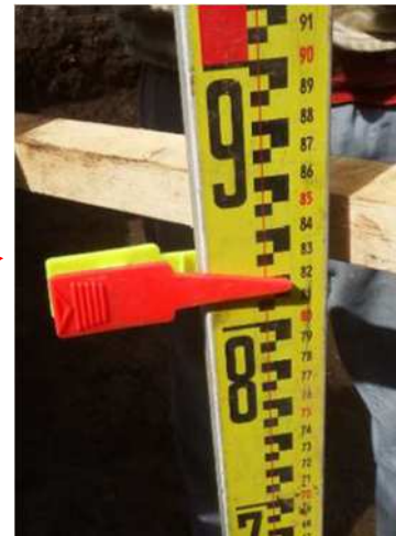
舗装面からコンクリート構造物の躯体まで 82cm
