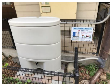
＜駒場野公園 雨水タンク＞ 2020（令和2）年度 啓発のため設置
