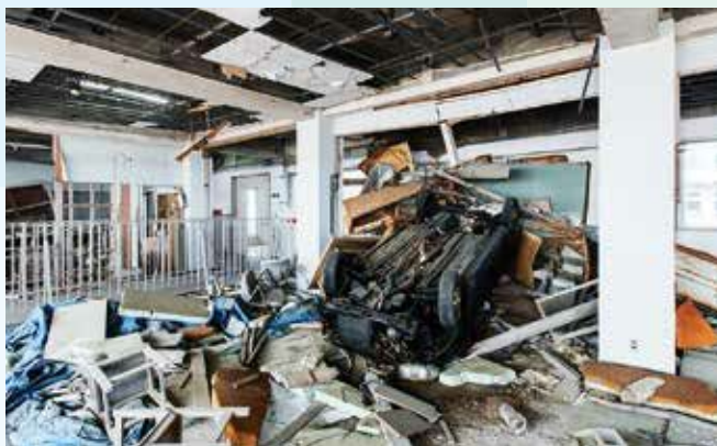
▲破壊された校舎。押し流された車も当時のまま保存されている
