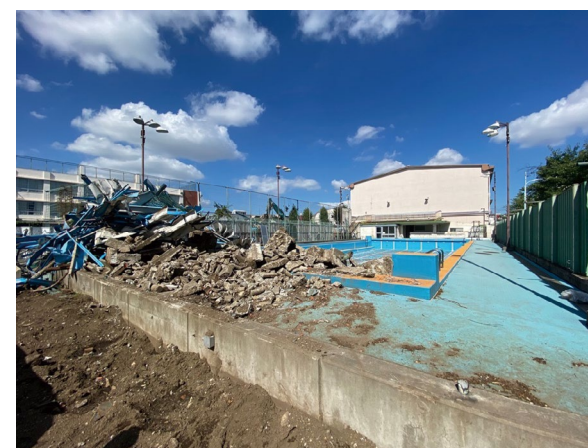
プール解体工事は10月に完了
