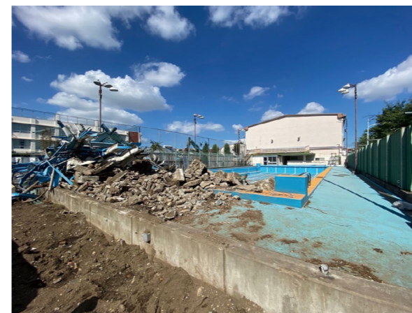
プール解体工事は10月に完了
