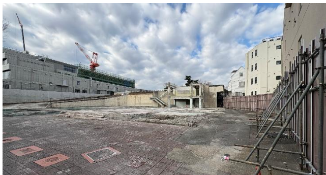
▲既存校舎解体後の様子（東側）
