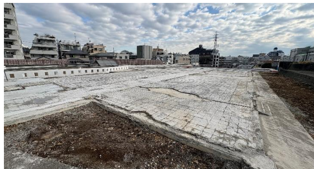
▲既存校舎解体後の様子（西側）
