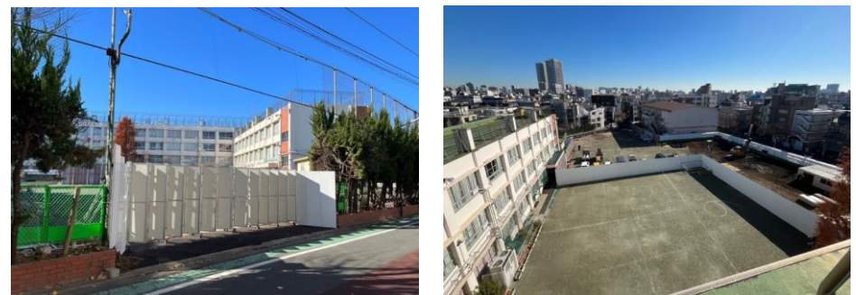
仮設校舎の建設
