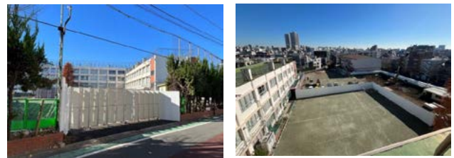
仮設校舎の建設
