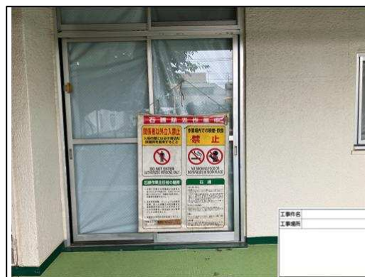
作業看板設置
