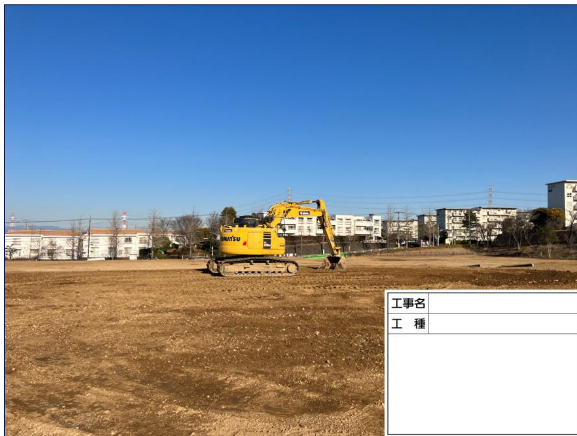
整地作業状況
