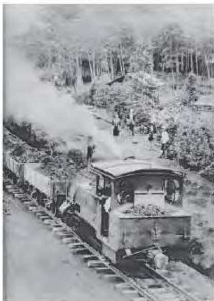
鉄道開通前後、柿の木坂付近の竹やぶと東横線の工事(昭和初めころ)
