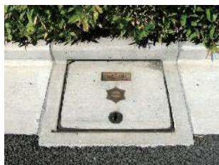
設置した雨水浸透枳
