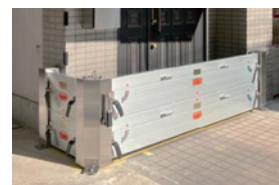
止水板の設置例
