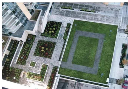
高層ビルの屋上緑化 雨水管理だけでなく、屋根を保護する効果 なども期待されている。
