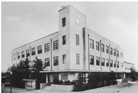
写真 2-1 昭和 11 年竣工時の区役所庁舎 R
