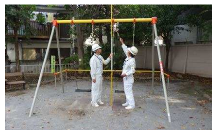
公園施設の点検のようす
