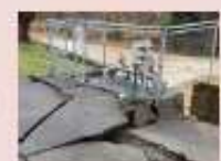
水道の復旧 (被災した浄水場)
