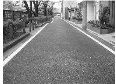
◀ 保水性舗装した道路 ▶
