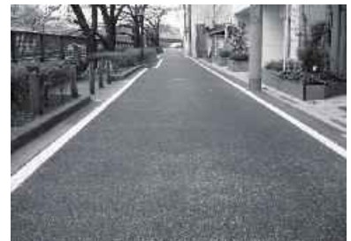
＜保水性舗装した道路＞
