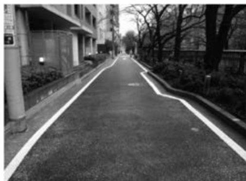
＜保水性舗装した道路＞
