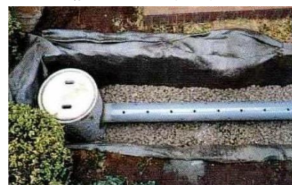
＜敷地内の雨水浸透トレンチ＞
