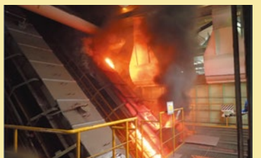
中防不燃ごみ処理センターの火災の様子(令和2年11月)©清掃一組
