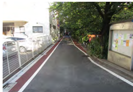
<保水性舗装した道路>
