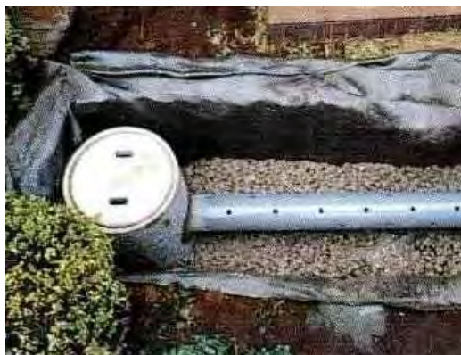
<敷地内の雨水浸透トレンチ>
