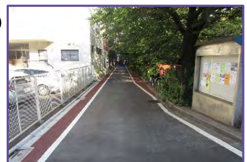
<保水性舗装した道路>
