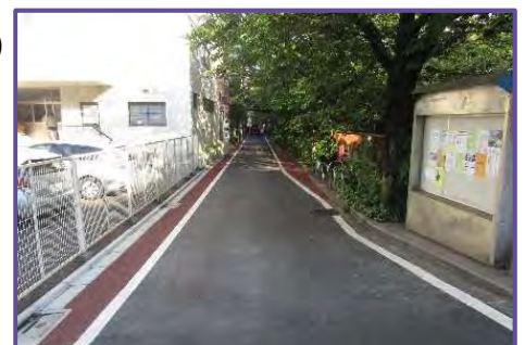
<保水性舗装した道路>
