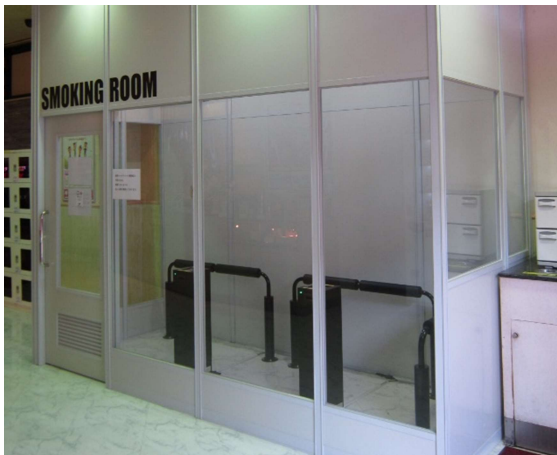
＜補助事業により整備した屋内型喫煙施設＞
