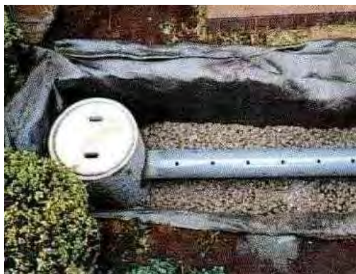
<敷地内の雨水浸透トレンチ>
