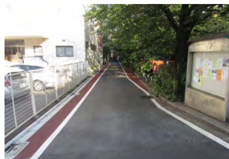
<保水性舗装した道路>
