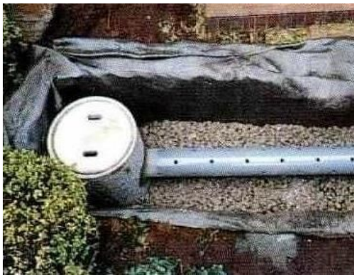
<敷地内の雨水浸透トレンチ>
