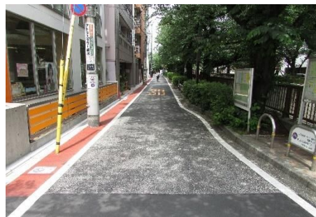
<保水性舗装した道路>
