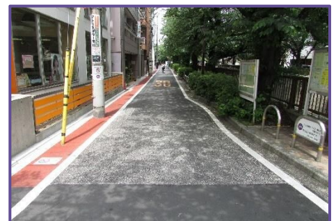
<保水性舗装した道路>
